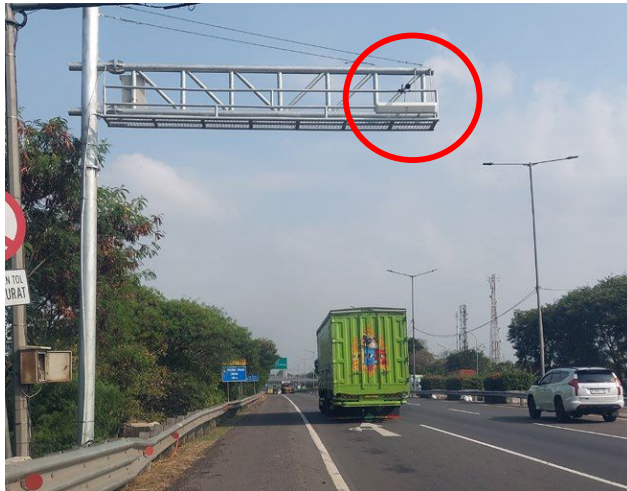
Gambar 3. Pemanfaatan Weighted-in-Motion (WIM) terintegrasi data Uji Berkala, RFID, dan UPPKB untuk pengawasan dan pencatatan pelanggaran lebih dimensi-lebih muatan
