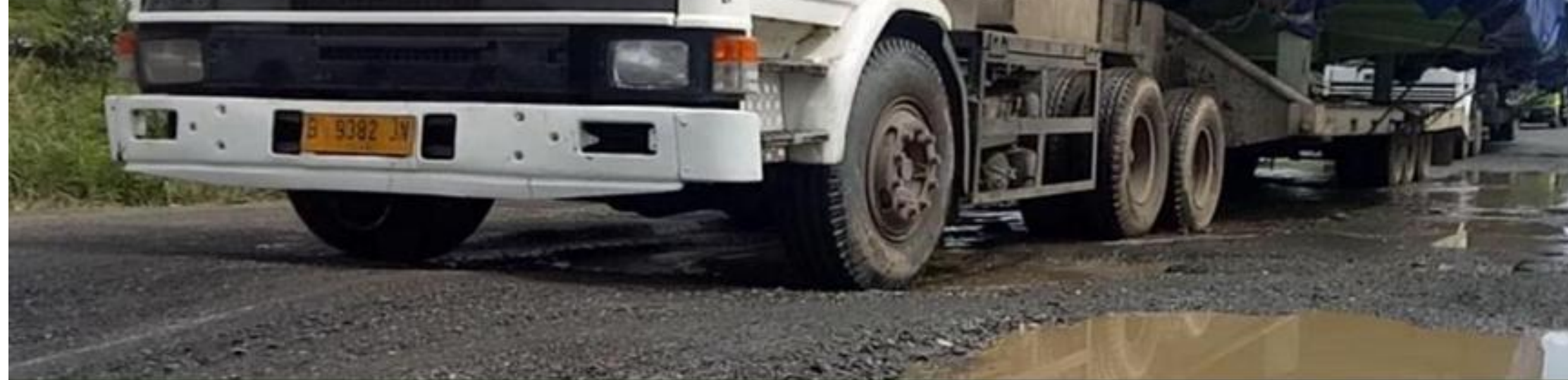
Penyebab Kerusakan Jalan
